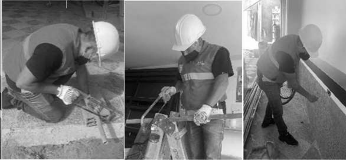
Figura 6. Trabajador de Av. constructores S.A.S, haciendo uso de E.P.P Fuente: Elaboración propia
