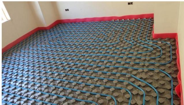
Figura 22. Ejemplo de suelo radiante <sup>26</sup>
