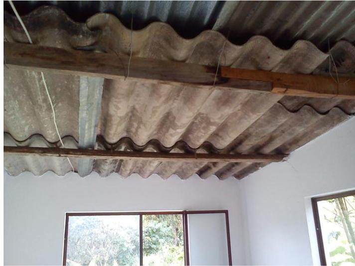
Figura 42. Vigas donde se colgarán las 8 bolsas de 12 Kg y se dispondrá la manguera de rocío
