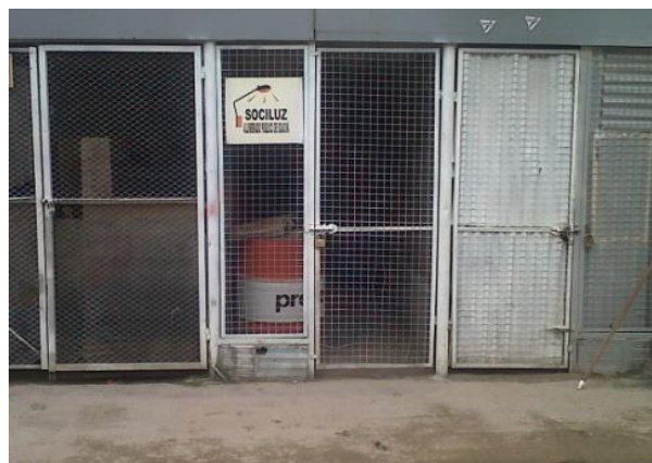
Fotografía 5. Cuarto de almacenamiento RESPEL- Entrada 2
