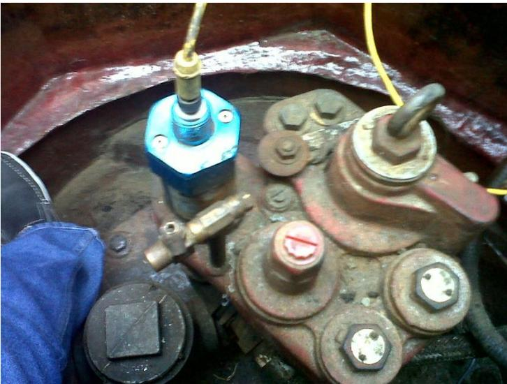
*Ilustración 22 Transductor de Presión (FRANKLIN FUELING SYSTEMS, s.f.)*
