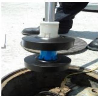
En esta imagen los flotadores limpios sin sedimentos, y las conexiones en buen estado. La consola reconoció las sondas y se habilitaron las mediciones.
