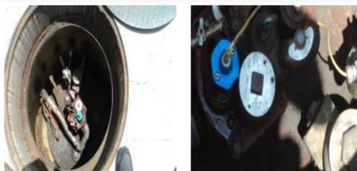
En esta imagen vemos una pequeña humedad, se debe de revisar al igual que las válvulas cheque de retención, para que sostengan la presión y la señal por baja presión permita hacer interface entre los equipos y el tablero para combustibles.
