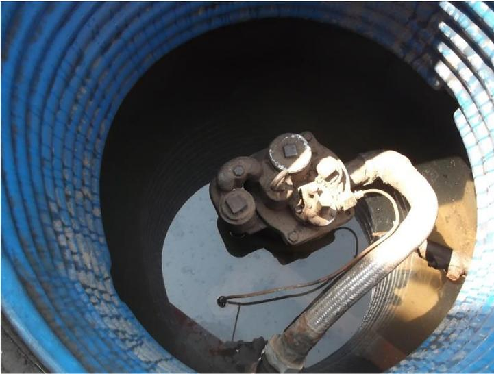
*Ilustración 21 bomba sumergible evidencia filtración de agua (FRANKLIN FUELING SYSTEMS, s.f.)*
