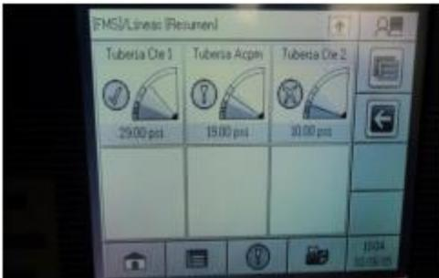
En esta imagen el estado de presión de las líneas y los transductores en comunicación con la consola, notándose despresurización en las líneas de ACPM y de corriente 2.
