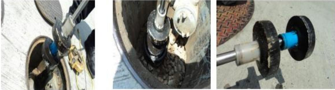
En esta imagen los flotadores con excesiva sedimentación, lo que altera la medición electrónica.
