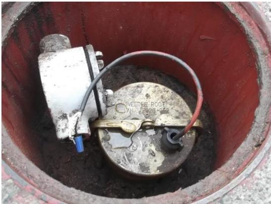
*Ilustración 19 sonda magnetostrictiva (FRANKLIN FUELING SYSTEMS, s.f.)*
