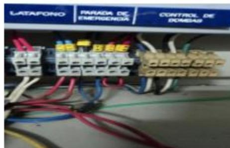
En esta imagen esta la línea del tanque corriente 2 deshabilitada totalmente por la consola y en el tablero esta puenteada anulando el bloqueo por baja presión.
