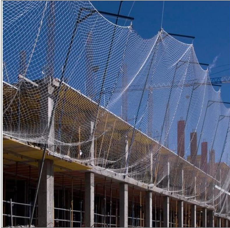
Imagen 15 redes de protección con nudo (imagen tomada de http://unmundoderedes.com/ )
