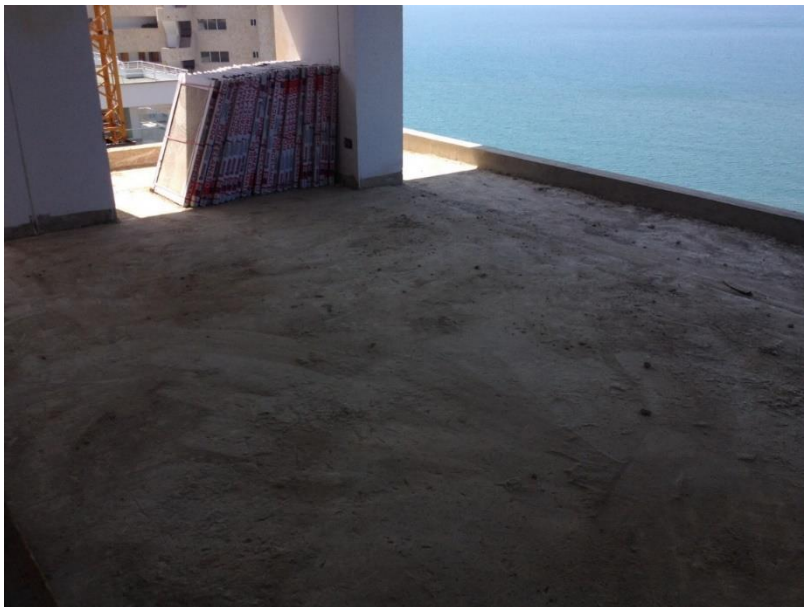
Imagen 6. Material descargado dispuesto en borde de losas
