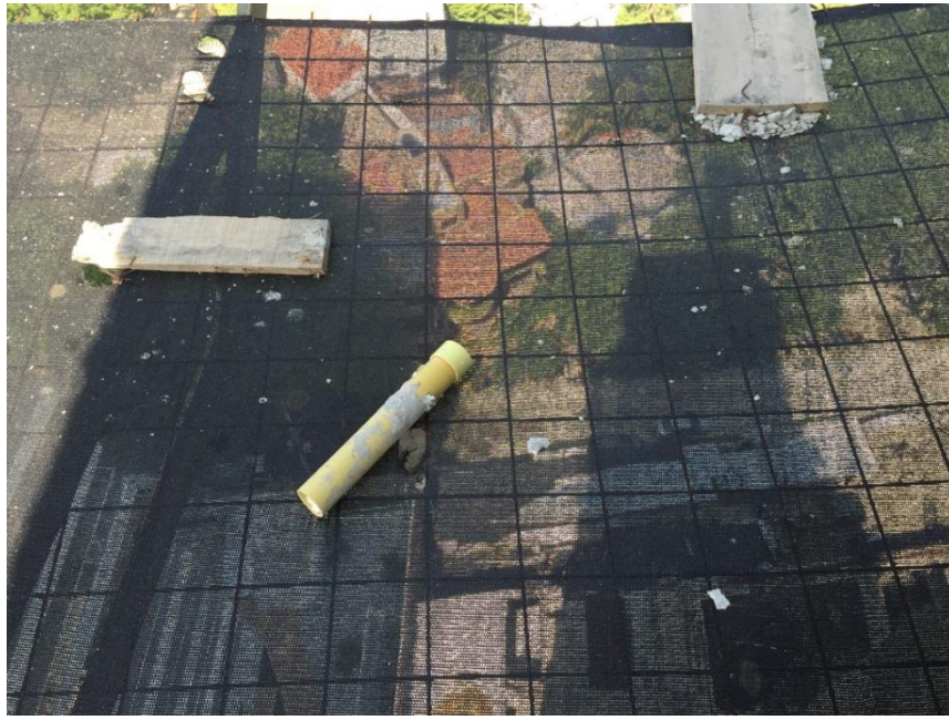
Imagen 13. Método de protección colectiva (mallas de seguridad)
