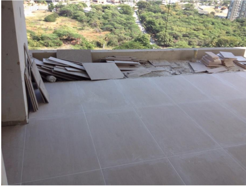
Imagen 3. Materia de trabajo (enchape) almacenado en bordes de losa.
