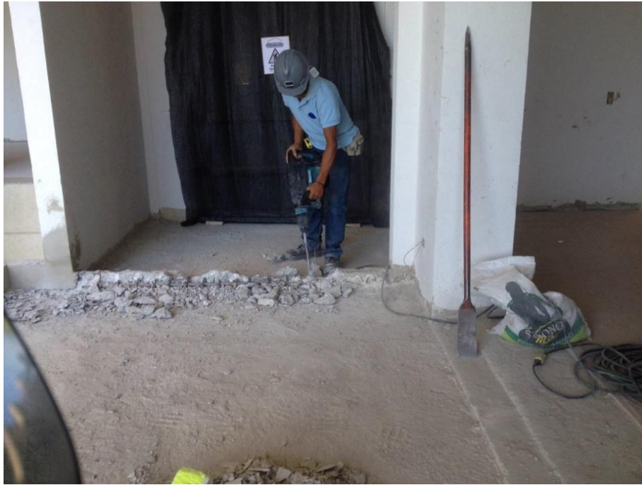
Imagen 1. Alistamiento de piso borde placa para enchape
