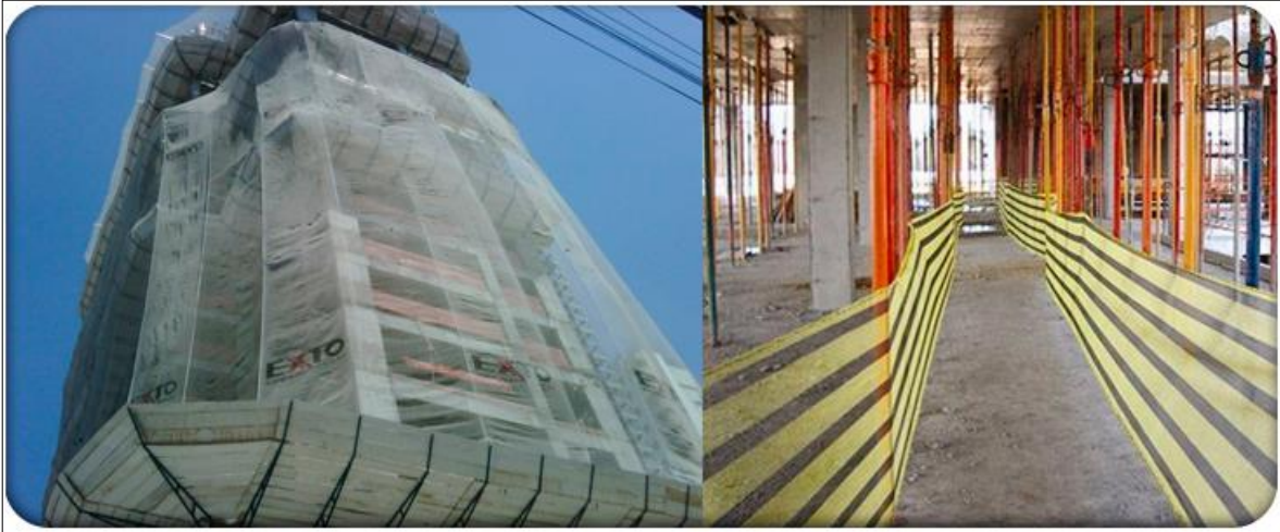
Imagen 17 mallas de protección plásticas (imagen tomada de http://unmundoderedes.com/ )
