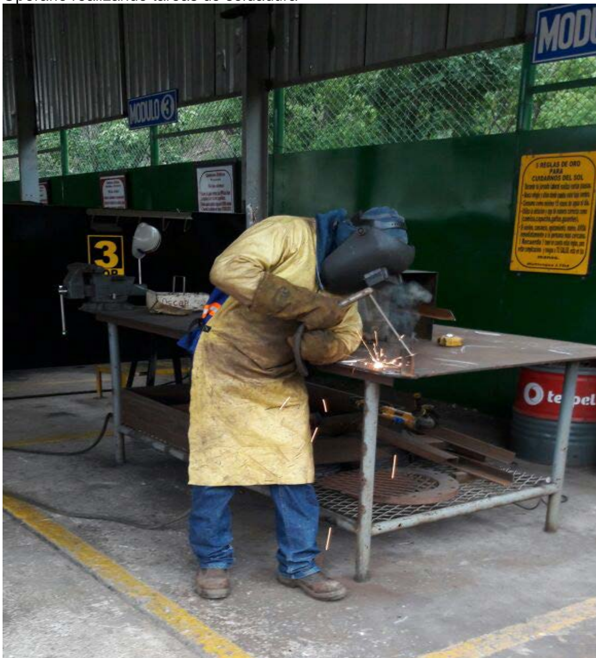
Operario realizando tareas de soldadura
