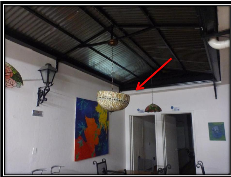
Fotografía.18. elemento pesado en lugar alto con deficiencia de anclaje
