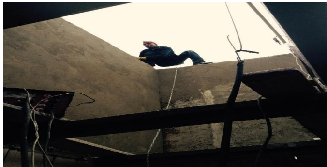
Fotografía No.9 Metálicas Gutiérrez área de montaje foto tomada en visita de campo por autores de la investigación
