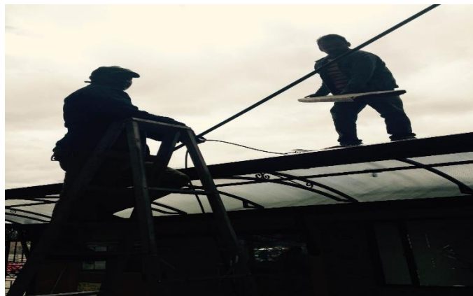
Fotografía No.10 Metálicas Gutiérrez área de montaje foto tomada en visita de campo por autores de la investigación
