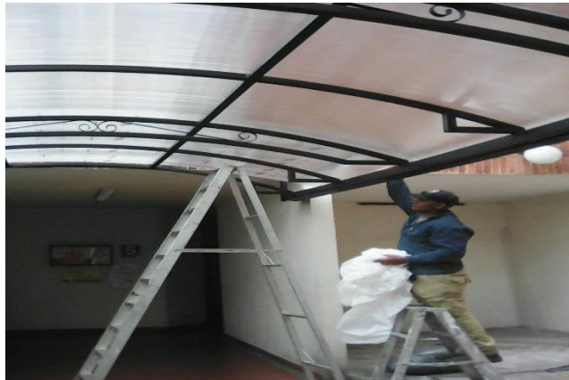
Fotografía No.12 Metálicas Gutiérrez área de montaje foto tomada en visita de campo por autores de la investigación
