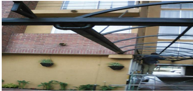
Fotografía No.8 Metálicas Gutiérrez área de montaje foto tomada en visita de campo por autores de la investigación
