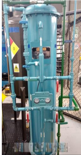
Figura 28. Suavizador de agua planta térmica piloto [autores].
