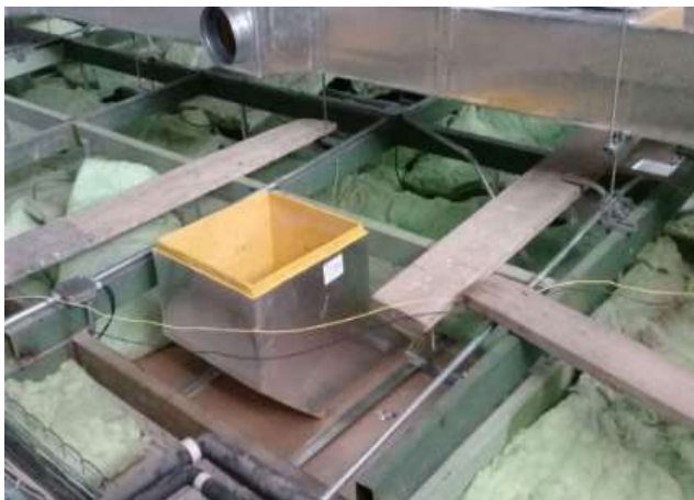
Figura 8: Canales donde está presente la fibra de vidrio en la Empresa Mardani S.A.S.
