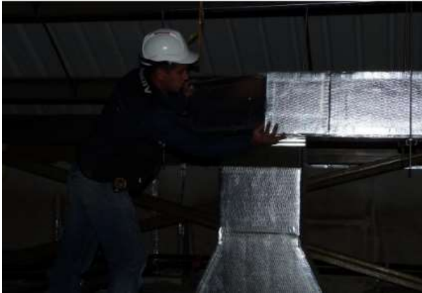
Figura 6: Falta de EPP en la Empresa Mardani S.A.S.
