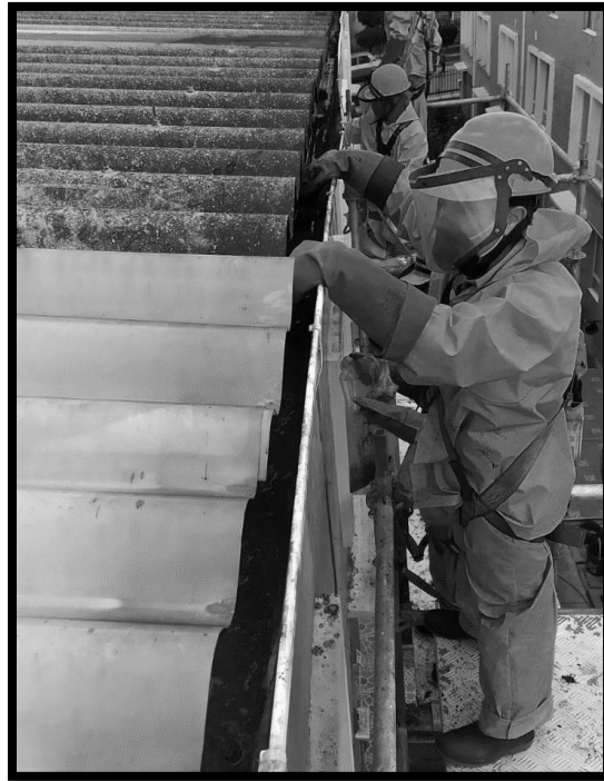
Ilustración 7 Instalación de techos
