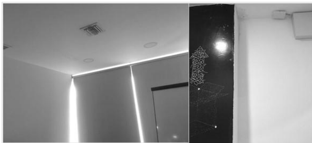
Foto 6: Condiciones locativas paredes
