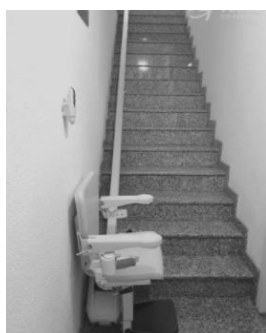
Foto 5: Escalera de acceso sin barandas
