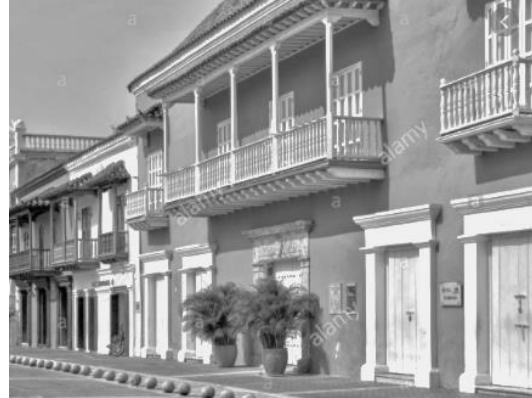
Foto 2. Fachada Oficina Administrativa
