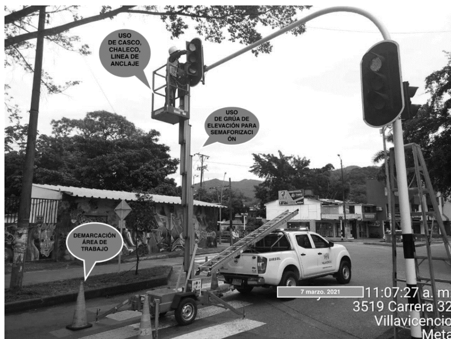
Figura 6 Demarcación de área y uso de equipos y herramientas en actividad de mantenimiento de semáforos
