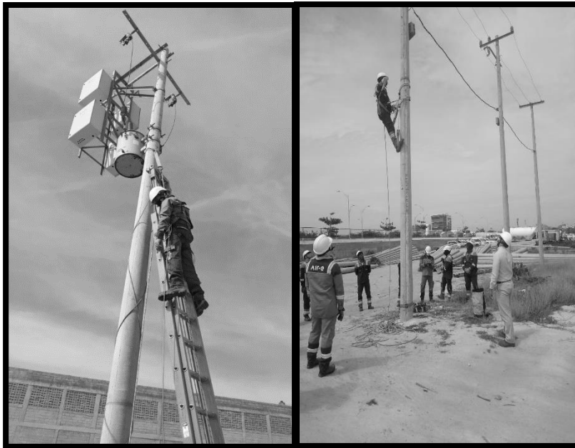
figura 8. Formación en trabajo en alturas, mediante el uso de escaleras y pretales para el sector eléctrico
