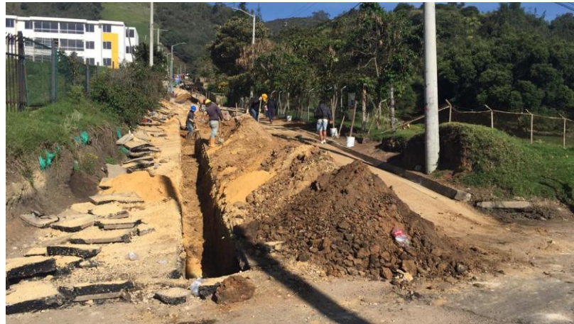
Ilustración 7. Reemplazo de la red pluvial existente – Constructora Fractal
