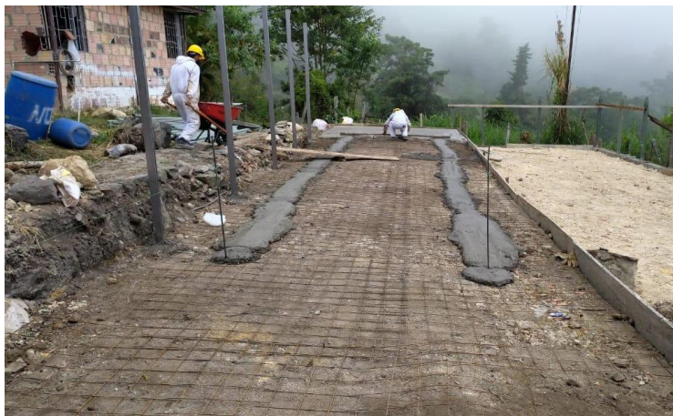
Ilustración 9. Fundición de placa – constructora Fractal
