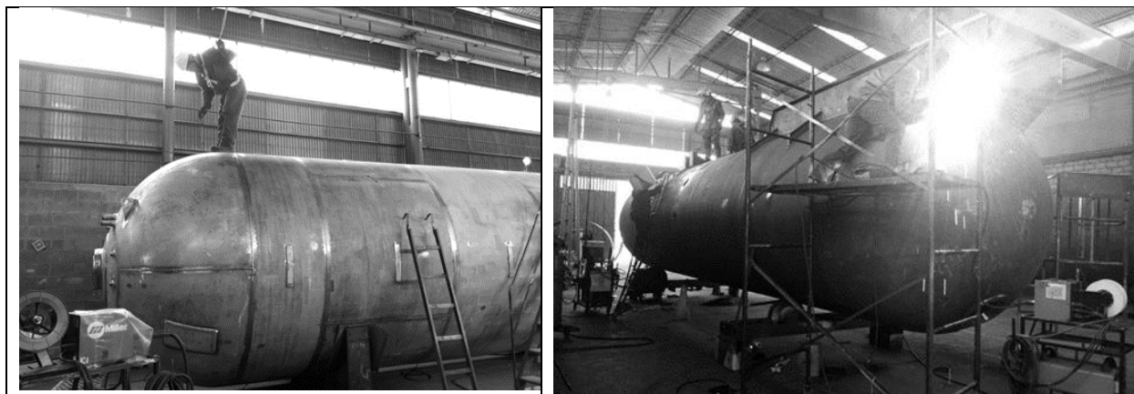
Figura 5. Actividades que requieren trabajo en alturas
