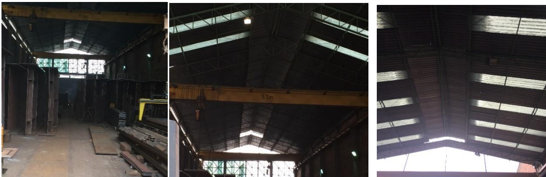
Imágenes 18 - 20: Instalación de algunas tejas traslúcidas en la Planta Antigua.
