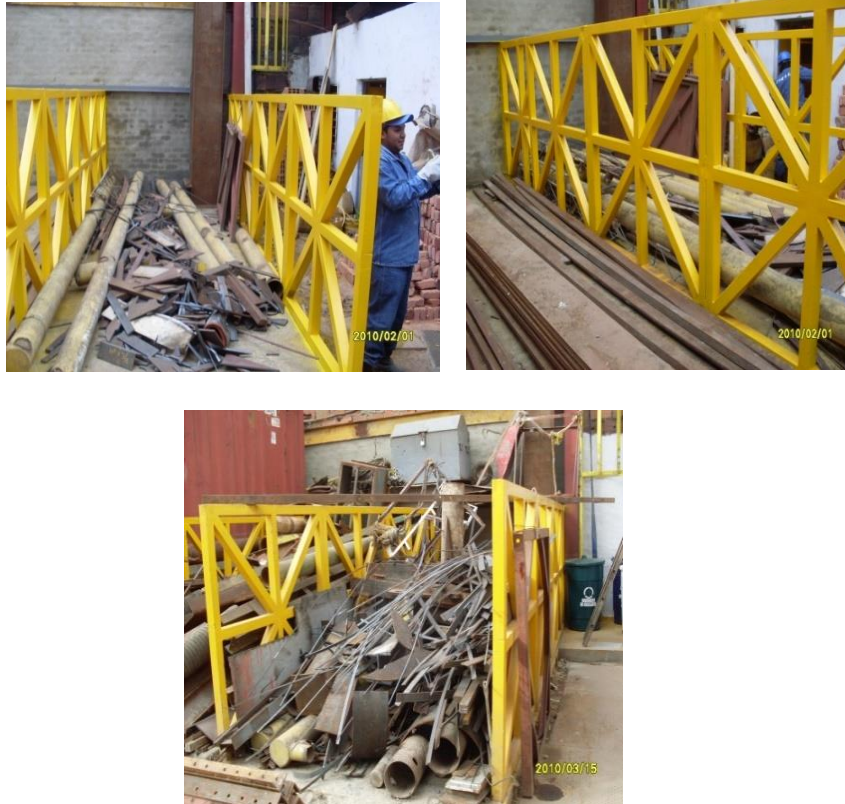
Imágenes 54 – 56: Adecuación de actual sitio de almacenamiento de chatarra. Fuente: Autoras.
