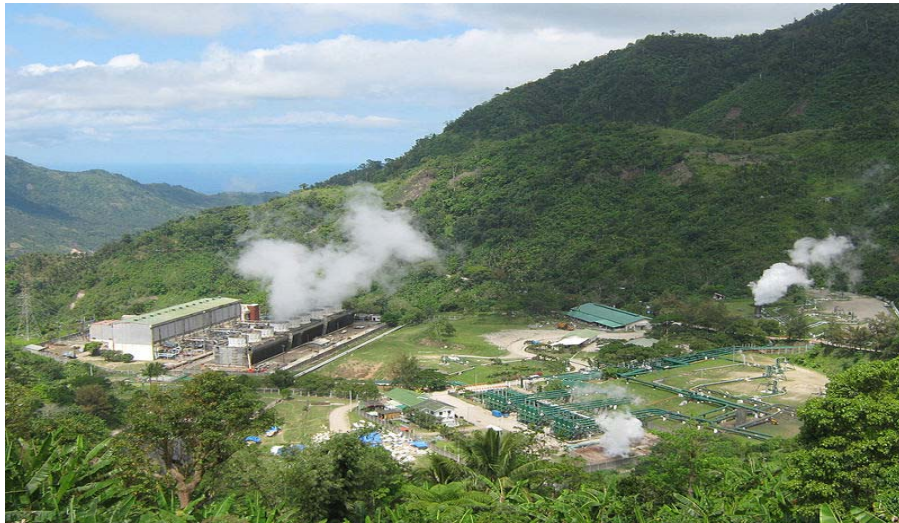
Figura 3. CENTRAL GEOTERMICA PUHAGAN FILIPINAS [4].
