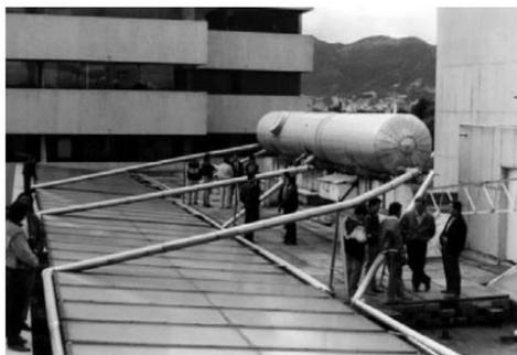
*Ilustración 7 Calentador de la cafetería de la antigua Empresa de Energía de Bogotá (EEB)*
