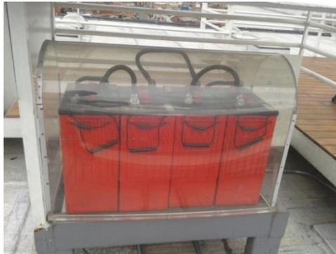
*Ilustración 8 Baterías ROLLS S-530*
