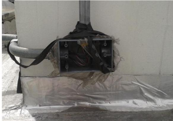
*Ilustración 12 Conexión expuesta al ambiente.*
