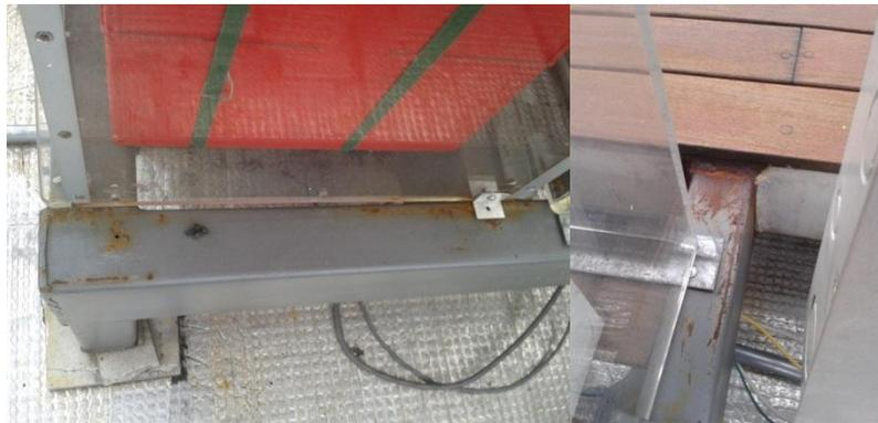
*Ilustración 11 Estructura del sistema eléctrico: Baterías y convertidores, deteriorados por la oxidación.*
