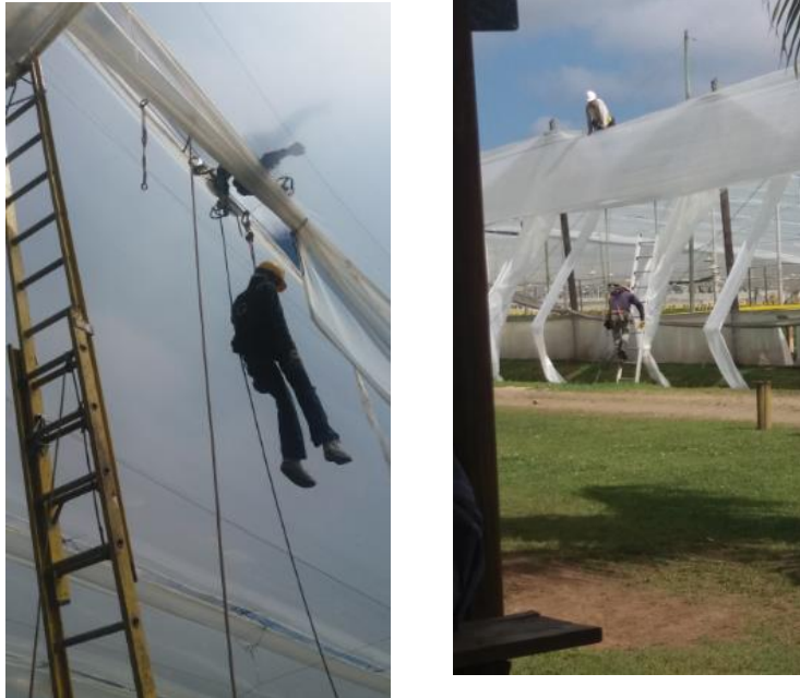
Imagen No.3. Montaje Invernadero tipo capilla en empresa del sector floricultor de Rionegro.
