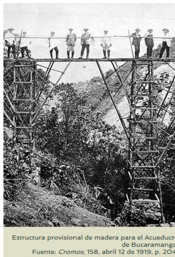
Ilustración 3 estructura provisiona de madera para el acueducto
