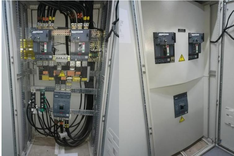
*Ilustración 7 Contactores motorizados de red y planta, fuente: CDP de Codensa.*
