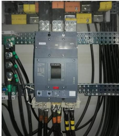
*Ilustración 8 Breaker de protección potencia de 800 Amperios fuente: CDP de Codensa*
