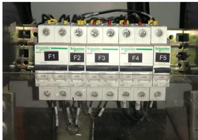
*Ilustración 10 Breaker de protección control 6 Amperios fuente: CDP de Codensa*
