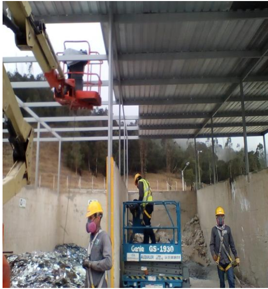
Foto No. 6 Instalación de tejado en empresa de cliente.
