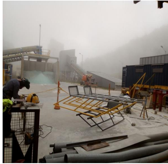
Foto No. 7 Fabricación y corte de estructuras metálicas para empresa de producción de vidrio.
