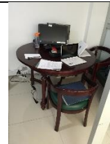
Área comercial, se evidencia puestos en condiciones antiergonómicas, cables sin canalizar iluminación deficiente.
