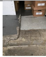
Archivo, pisos con desniveles
