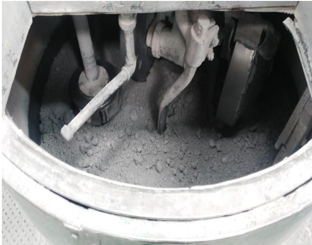
Ilustración 17 Mezcladora, Sistema de Mezclado. Fuente: Los Autores.
