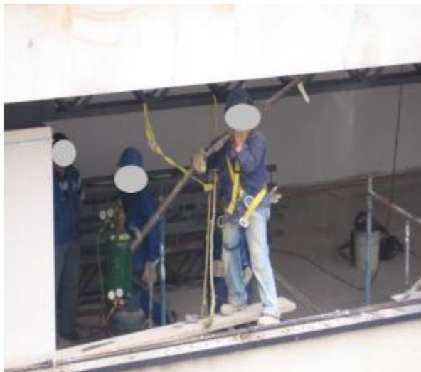
Figura 6. Elemento estructural utilizado como punto de anclaje. (Fuente: BARON, Germán. Proyecto de Seguridad Industrial participativa)
