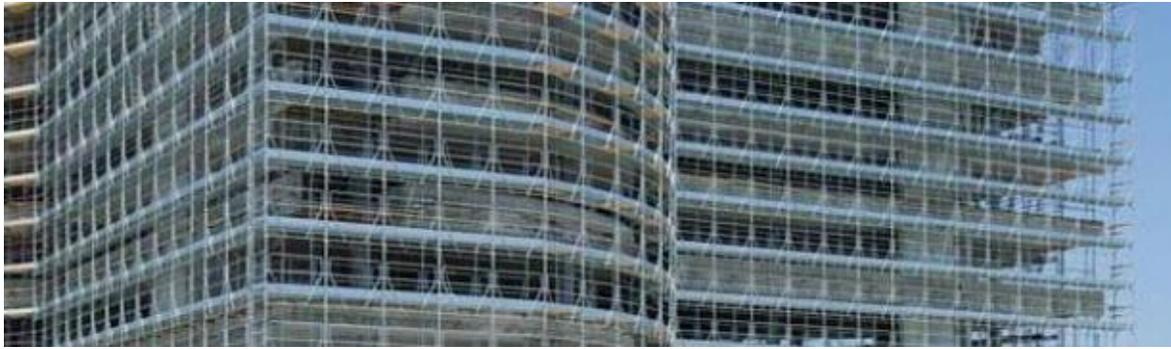
Figura 2. Andamio tipo multidireccional metálico modular. (Imagen tomada pagina Ovacen.com)
