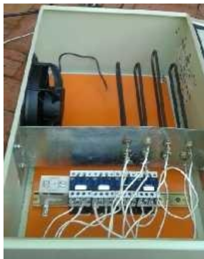
Imagen 11: Construcción del banco de carga.
