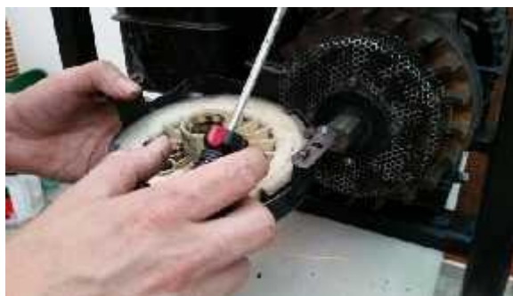
Imagen 13: Mantenimiento de la planta generadora.
