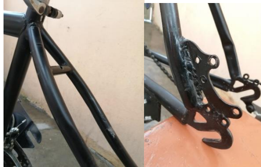
Ilustración 24 Rediseño para la adaptación del freno de disco. (De los autores)
