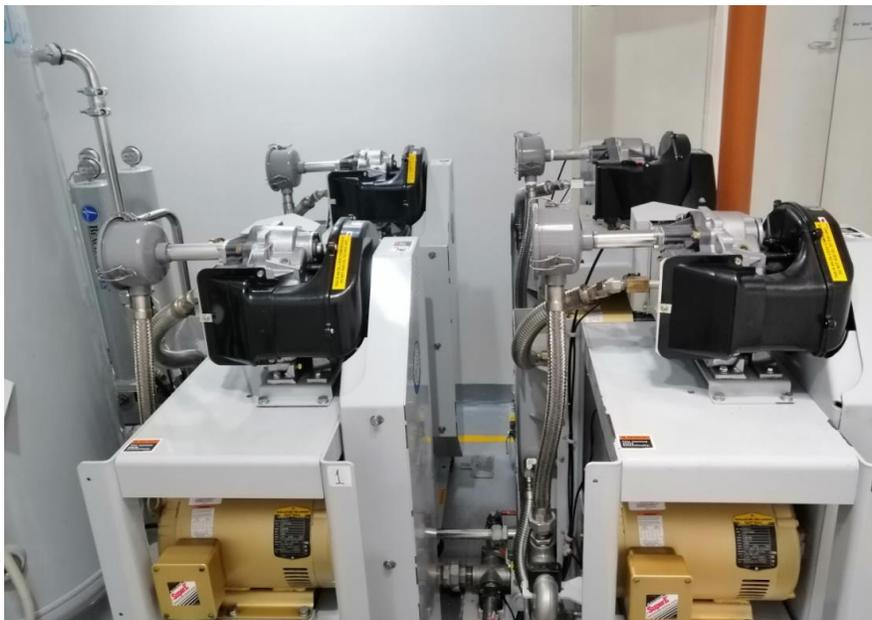
*Figura 2. Sistema de generación de aire medicinal cuádruple. Elaboración propia.*
