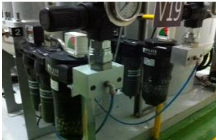
*Figura 6. Muestra la instalación de los filtros y el sistema de secado*
