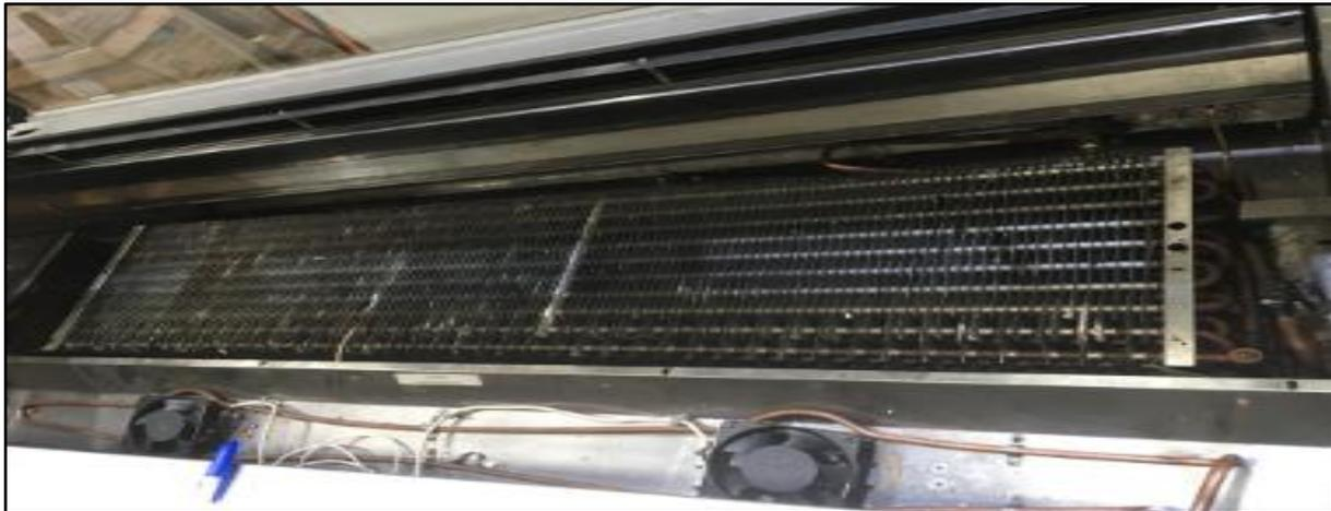
Después de realizar estudios de diseño, capacidad y autonomía se realiza la instalación del acumulador en el congelador de exhibición horizontal panorámico, el cual reemplaza el refrigerante por un líquido material de cambio de fase PCM, que permite mantener el núcleo del acumulador en una temperatura constante de hasta  $-40^{\circ}\text{C}$ , y este a su vez por medio de un control de temperatura no permite que los compresores se enciendan en un periodo de tiempo de aproximadamente 8 horas
