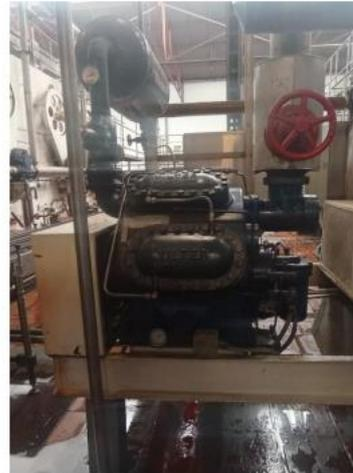
Se recomienda la instalación puntos de tierra de los motores 2 y 3 Realizar el cambio del aislante para empalmes del motor con líneas de potencia a cinta auto fundente y evaluar la instalación de bornera para evitar la aglomeración de cables y poder prevenir fallos de temperatura o corto circuito.
