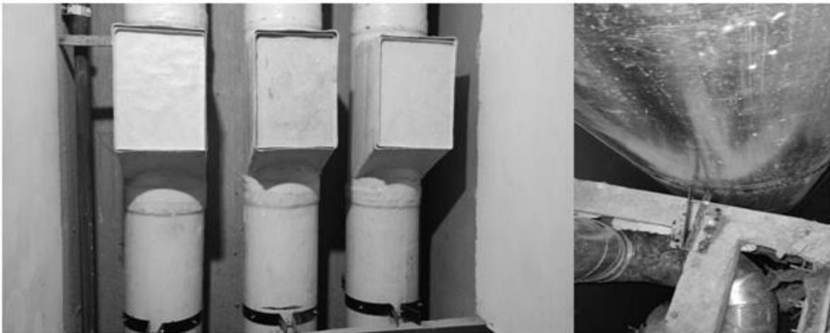
Anclaje con abrazadera en platina, con fijación a placa y apoyo posterior en pantalla de concreto
