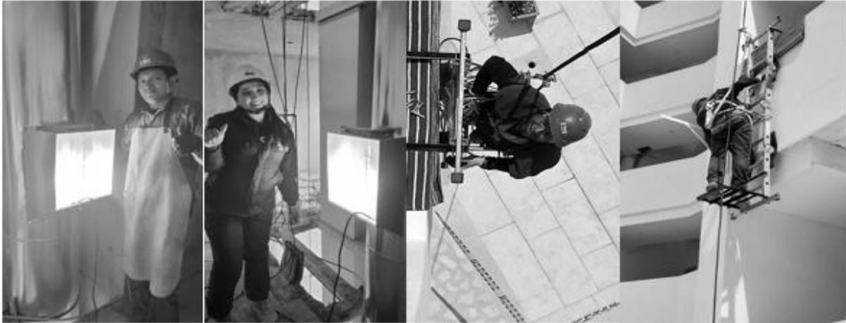
Instalación a nivel de piso, se utiliza según la Dimensión del vano, línea de vida, arnés y EPP.
