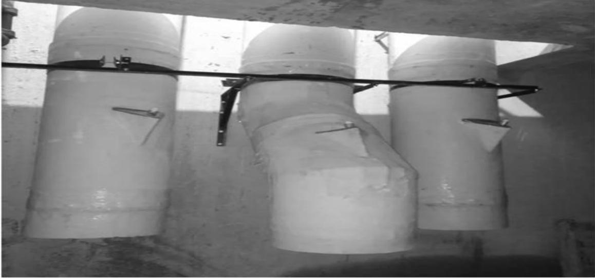
Anclaje con apoyo en pie de amigos en ángulo, abrazaderas y ángulo frontal para apoyo de estas, fijación a la pantalla de concreto mediante chazos expansivos
