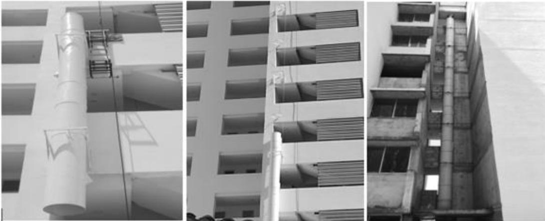
Instalación externa con pie de amigos en ángulo y abrazaderas a muro con ménsulas, fijación con chazos expansivos.
