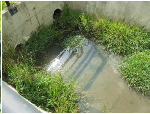
Figura 8 Tubería de descarga EBEL.
