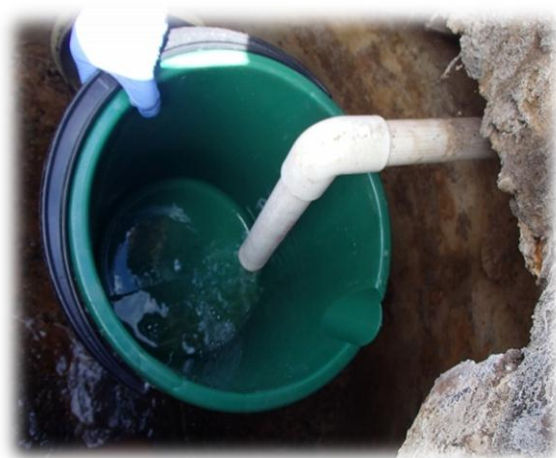
Fotografía 12. Medición volumétrica Manual
