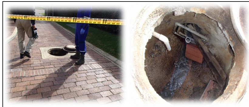
Fotografía 3. Reconocimiento de la PTARD salida del sistema del conjunto residencial Miraflores
