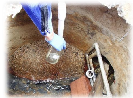
Fotografía 4. Toma de muestra de la PTARD salida del sistema del conjunto residencial Miraflores
