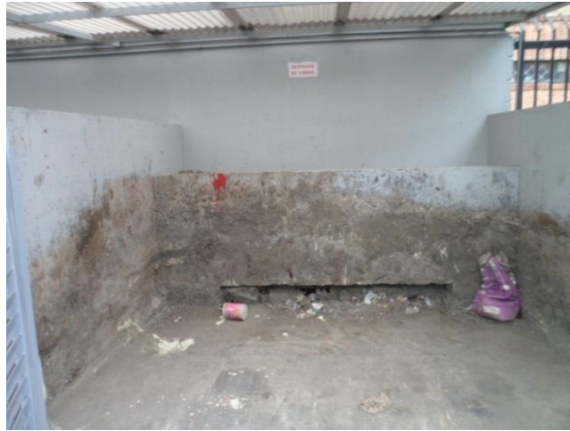
Figura2 cuarto de lodos
