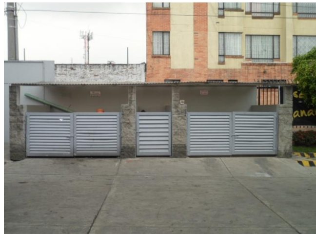
Figura3 . Vista frontal cuarto de almacenamiento residuos sólidos
