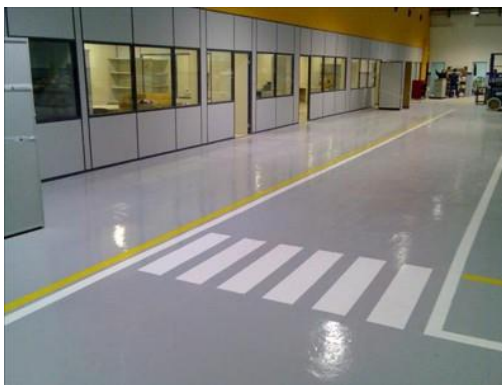
Img 1 (Piso de la bodega de almacenamiento)
