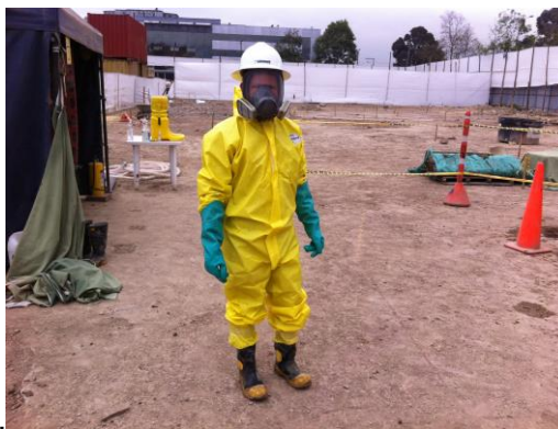
Img 11 (elementos de protección personal para el manejo de residuos altamente peligrosos)
