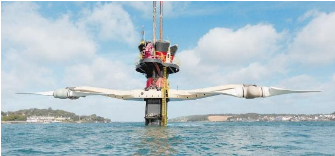
Figura 7. Plataforma Flotante Prototipo De Siemens.
