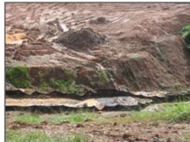
Fotografía N° 1 Fecha: 18 de Septiembre de 2013 Lugar: Zedra Campo Cohembi Observaciones: Etapa de construcción sedimentadores
