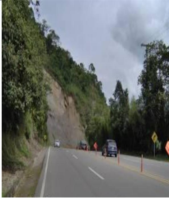
**Fotografía 21 Corte que quedo después del derrumbe en el Talud de La Vega Vía Bogotá-Villeta**
