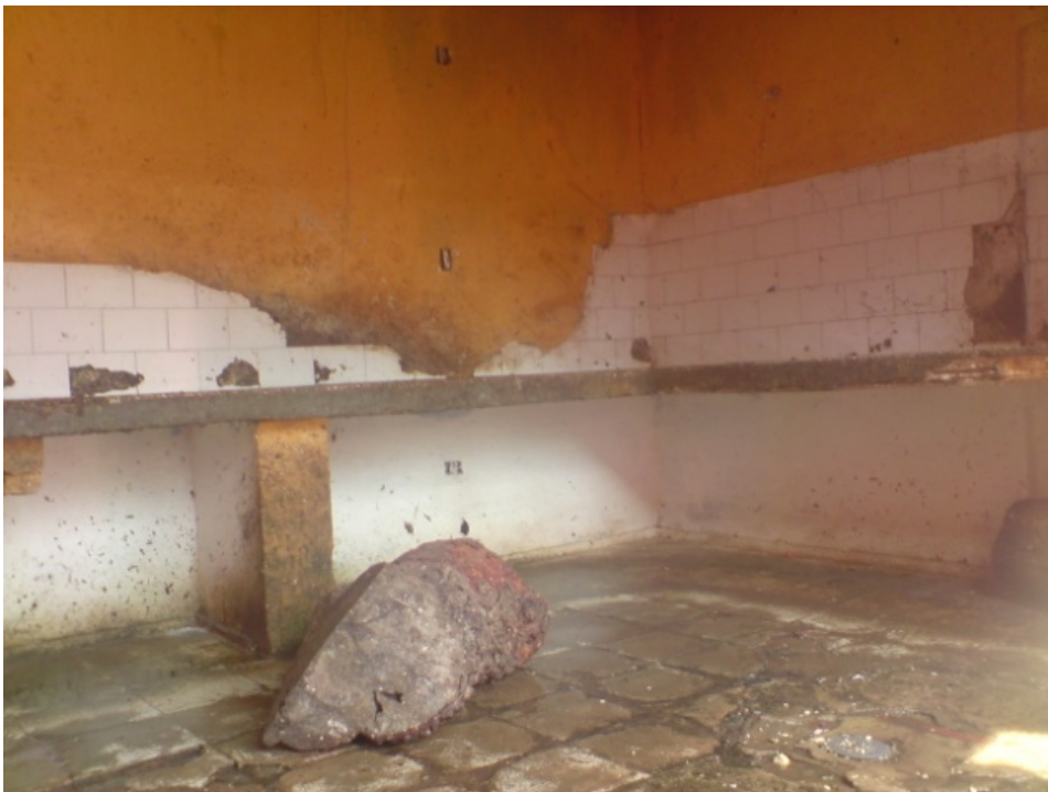
Figura 31. Estado actual de la plaza de mercado. Carmen de Bolívar, Bolívar. Fuente: Archivo fotográfico de los autores.
