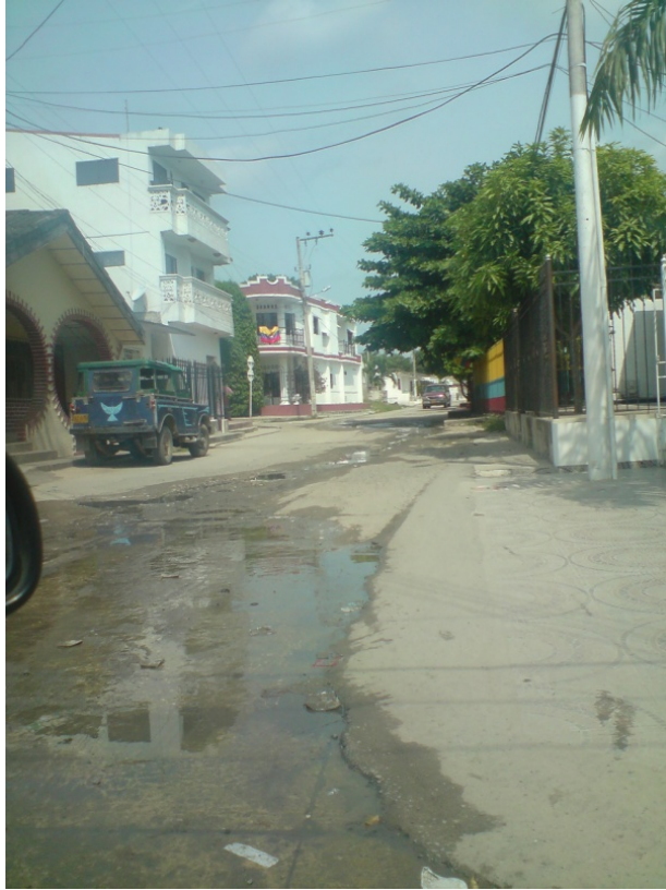
Figura 47. Aguas residuales en la vía por falta de alcantarillado. Manaure, La Guajira. Fuente: Archivo fotográfico de los autores.
