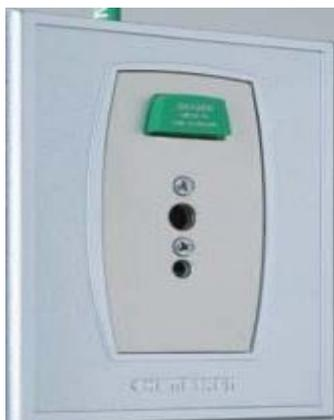
Al momento de realizar las rondas de seguridad en oncología oriente se evidencia que los seguros de los flujómetros duales están forzados por un seguro que está permitiendo el escape de fuga de oxígeno, por ende se retiran soporte y se realiza un comunicado para el departamento de mantenimiento de realizar nuevos soportes.
