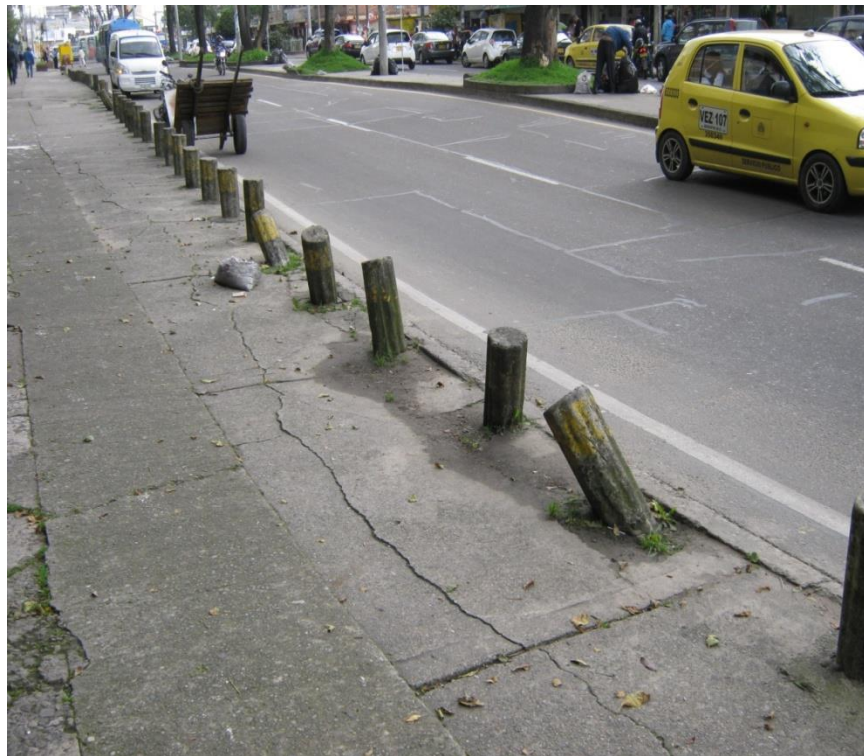
DIRECCIÓN: CALLE 24 CON CARRERA 36 A COSTADO OCCIDENTAL. Fuente: Autores
