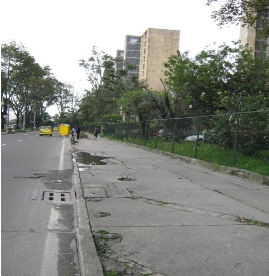
AVENIDA DE LAS AMERICAS CON TRANSVERSAL 32 C COSTADO NORTE. Fuente: Autores
