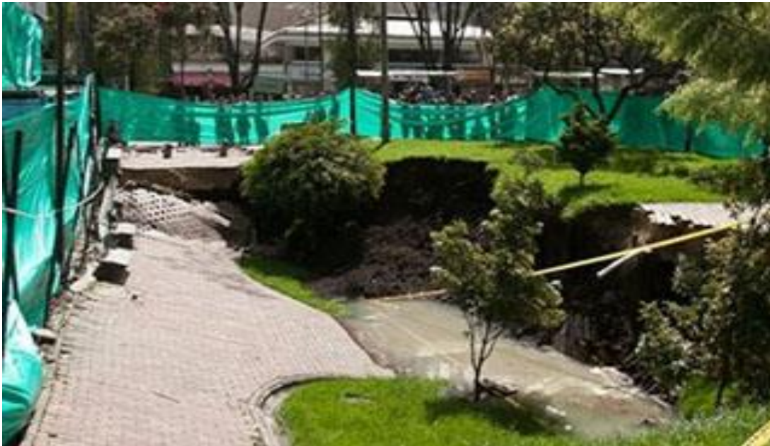
Fotografía 1. Hundimiento malla vial por emplazamiento de una construcción; Fuente: Ana María García /Diario EL TIEMPO Crra 11 con calle 98. Año 2013 Marzo 20
