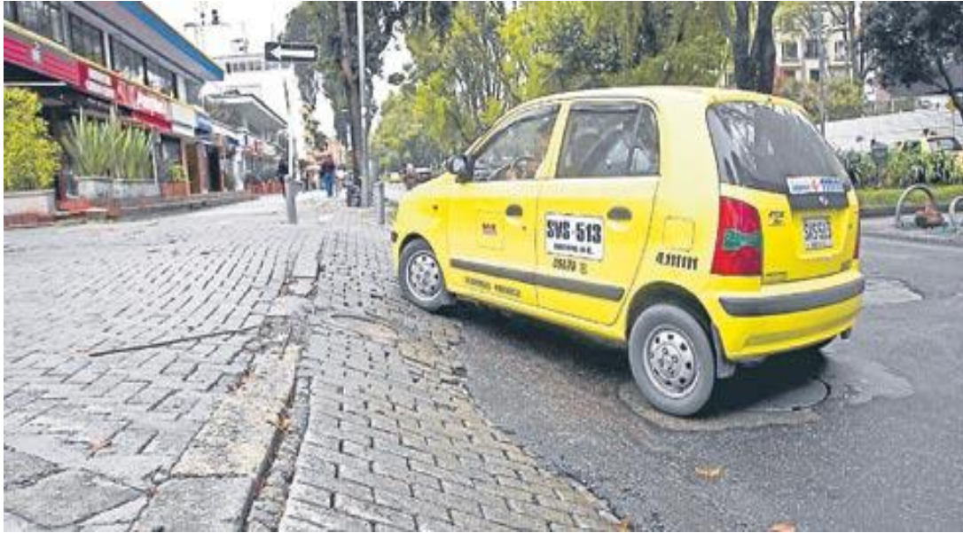
Fotografía 1. Hundimiento malla vial por emplazamiento de una construcción; Fuente: Ana María García /Diario EL TIEMPO Crra 11 con calle 98. Año 2013 Marzo 20
