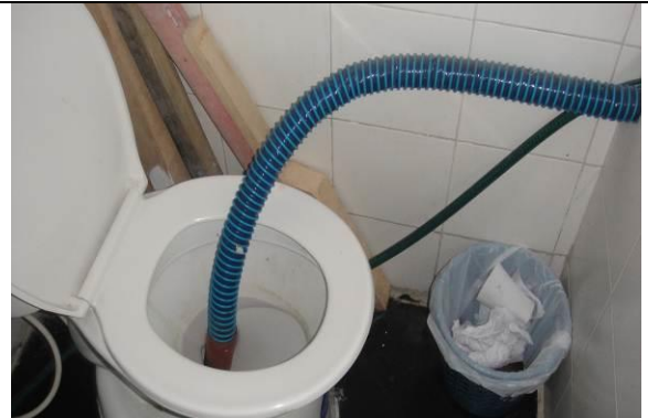
Foto 33. Descargue de agua residual producto de la bañera
