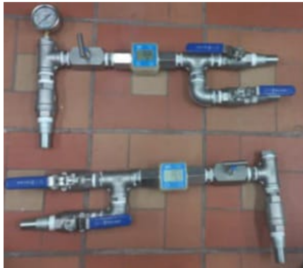
Figura 16. Líneas de vacío, Fuente propia
