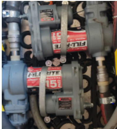
Figura 15. Bombas de alto caudal, Fuente propia
