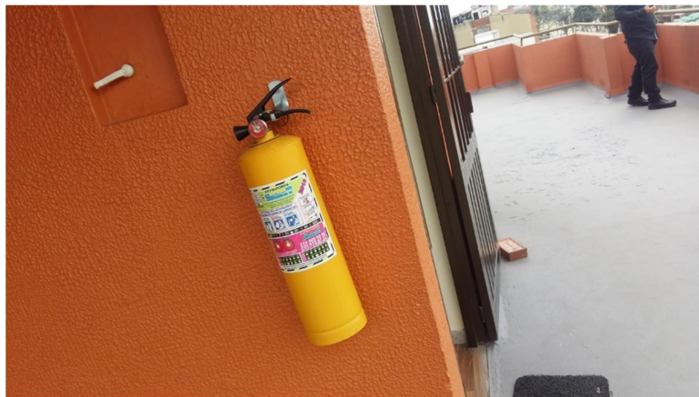
Figura 16. Instalación de extintor multifuegos.
