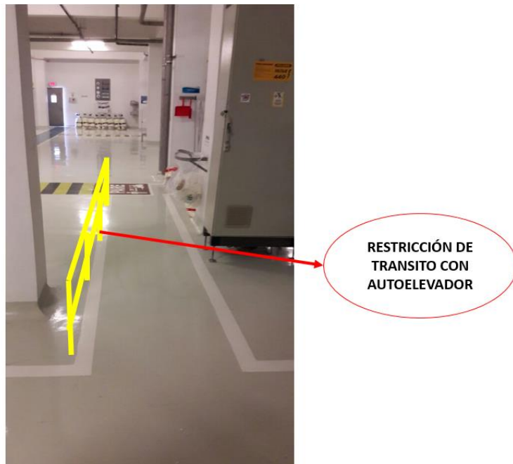
Ilustración 46. Propuesta instalación de barandas 3, sala de totes. Fuente: Autor
