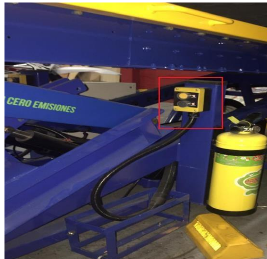
Figura 25. Botonera ascenso y descenso
