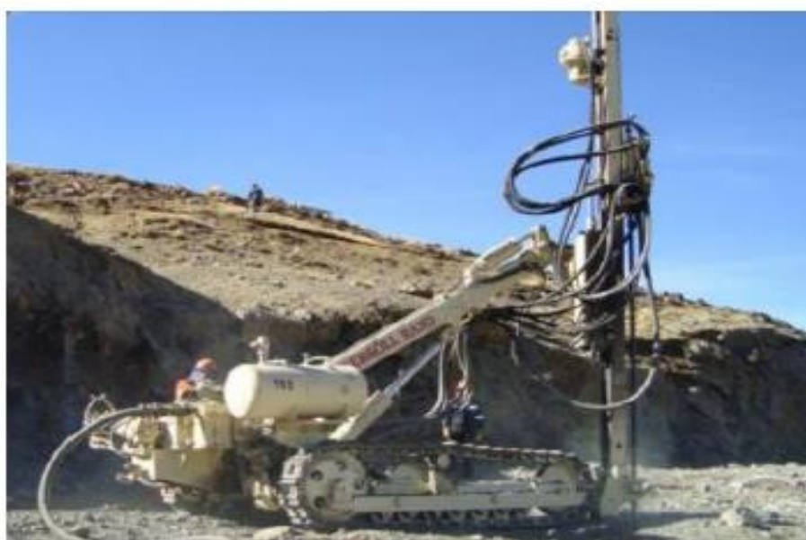
Ilustración 5. Perforadora Track Drill. Fuente: Otazú (2019)
