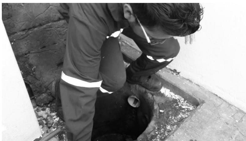
En esta imagen se identifica, que el técnico de campo no hace uso de la línea de vida, ya que realizará una toma de muestra en el fondo de la caja de inspección, ni tampoco hace uso del tapabocas.
