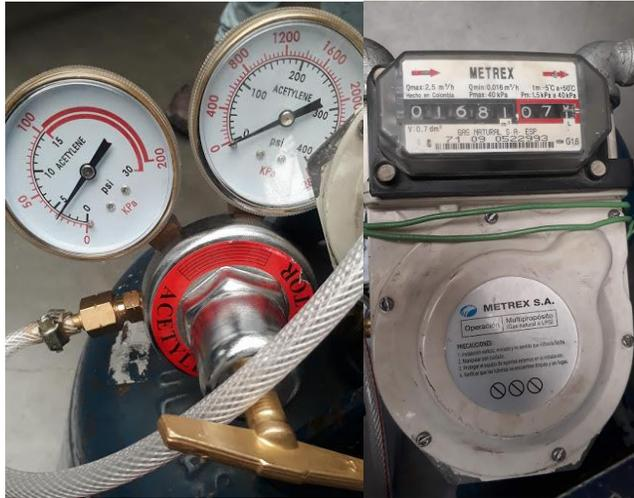
*Ilustración 36. Regulador de presión y contador de consumo de GLP.*
